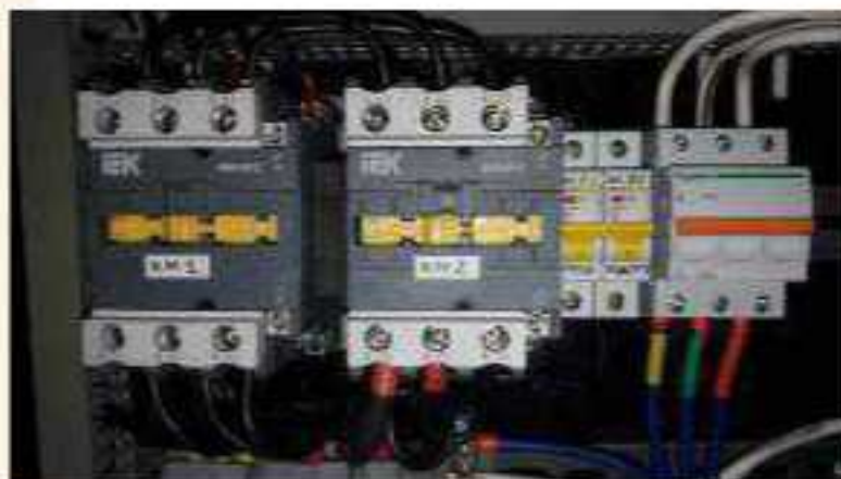
Контактор КМИ 18А, 50Гц 400В для аппаратов серии FX, F5 Германия
