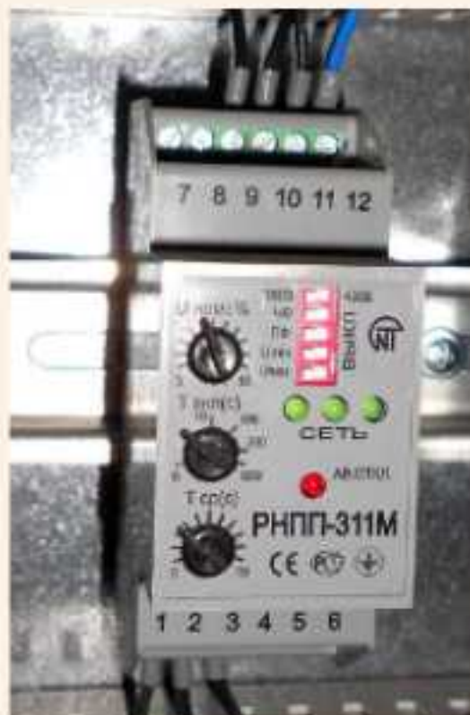
Трехфазное реле напряжения РНПП-311М Россия
